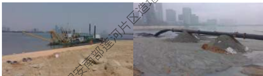
图 2.3-2 绞吸吹填示意图
